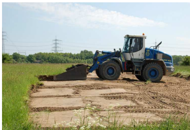
Verpflanzung einer Salbei-Glatthaferwiese in der Rheinaue (Kreis Wesel) mittels Grassodenverpflanzung (Foto W. Itjeshorst)
